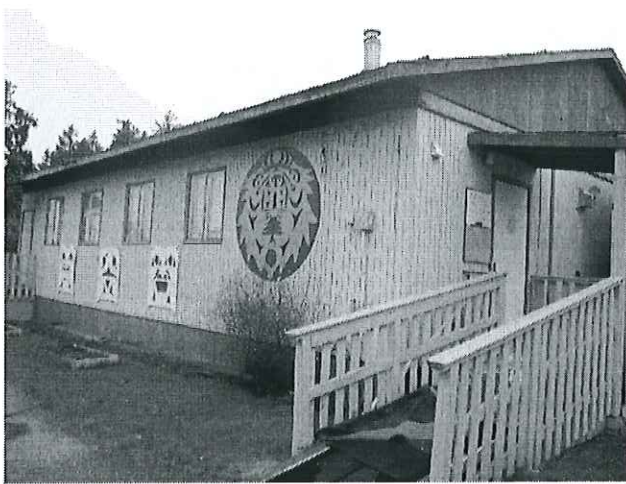
ラフウェルネフ民族学校附属保育園園舎
